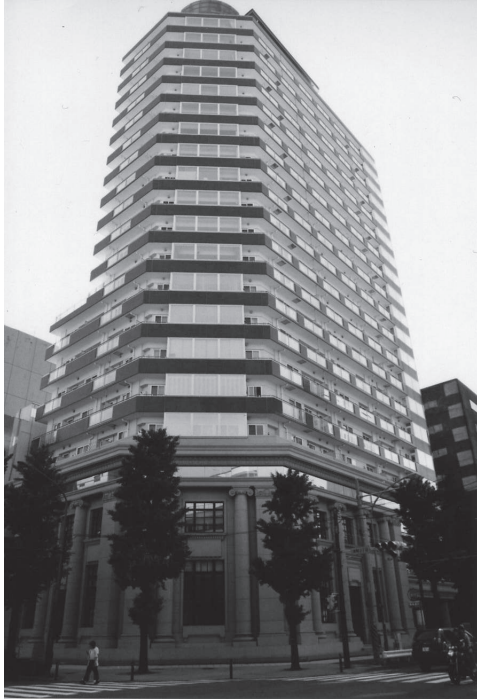
図1：低層部に銀行建築を用いるマンション (ディーグラフォート横浜クルージングタワー) 資料提供 = 国吉直行
