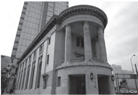
図7：左上＝工事時の日本興亜馬車道ビル／資料提供＝横浜市 図8：左中＝旧生糸検査所（現：横浜第二合同庁舎）／撮影＝中川ちあき 図9：左下＝旧横浜銀行本店別館（現：ヨコハマ創造都市センター）／撮影＝中川ちあき 図10：右上＝旧横浜銀行本店別館の曳き家／資料提供＝横浜市 図11：右下＝マンション下層部に外壁を復元（東京三菱銀行中央支店）／撮影＝中川ちあき
